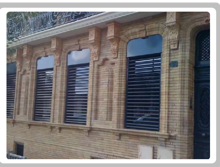
Fig.11 Exemple de pose avec lambrequin
