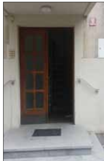
Sedanja vhodna vrata v blok se bodo zamenjala s takšnimi na avtomatsko odpiranje.
