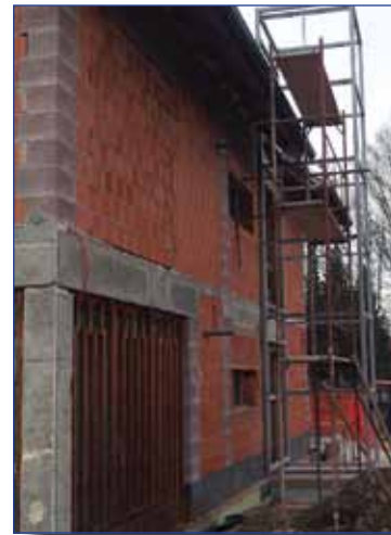
Takole je izgledala hiša pred gradnjo dvigala. Postavljena je kovinska struktura bodočega dvigala.
