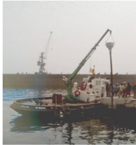
COULAGE DE BETON IMMERGE POUR CAVITE DE QUAI
