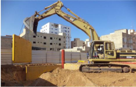
Mise en place du dispositif de rabattement de nappe et du blindage
