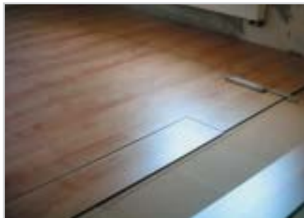
Betondecke mit AGEPAN® TEP und Laminatboden
