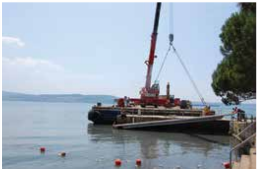
Slika 3: Izgradnja dovozne rampe
