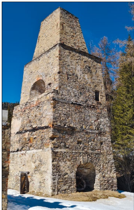
Talilna peč. Levo zgoraj odprtina za vsipanje, desno spodaj za izpust železa. Foto: Andrej Bogataj
