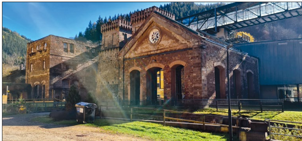
Železarski obrat v Heftu. Levo strojnica, na sredini peči, desno zgradba za oskrbo z zrakom. Foto: Andrej Bogataj
