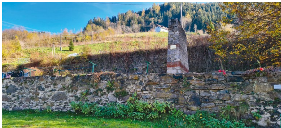
Zidani podporni steber železniške proge, s katero so v železarski obrat Eberstein dovažali rudo. Foto: Andrej Bogataj
