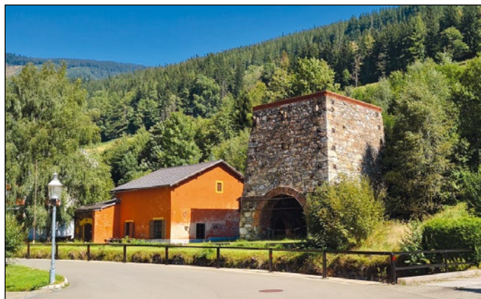
Radwerk III. Levo stavba za oskrbo z zrakom in delujočimi batnimi mehovi, desno peč ( Hochofen ). Foto: Andrej Bogataj
