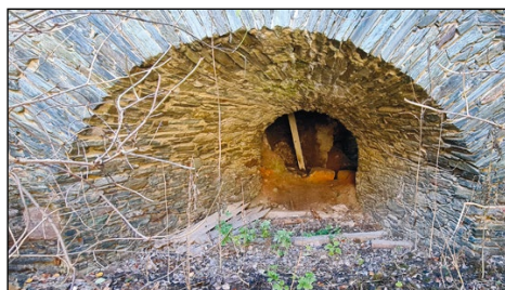
Spodnja odprtina za izpuščanje tekočega železa in žlindre. Foto: Andrej Bogataj
