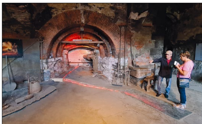
Radwerk IV. Spodnji del z izpustom taline, lito ploščo grodlja in preusmeritvijo žlindre v potok. Foto: Andrej Bogataj
