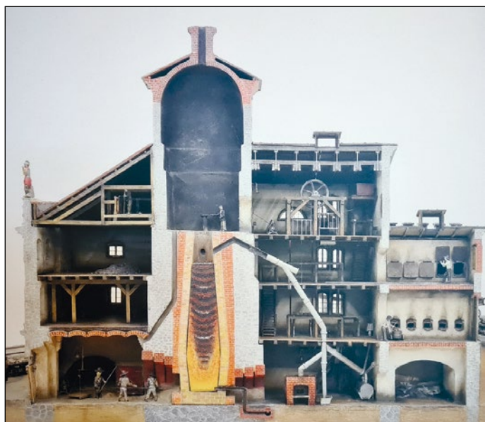
Model obrata Radwerk IV. Desno od peči je sistem za zajem plavžnih plinov, s katerim so ogrevali vpihavalni zrak in žarili rudo. Foto: Andrej Bogataj
