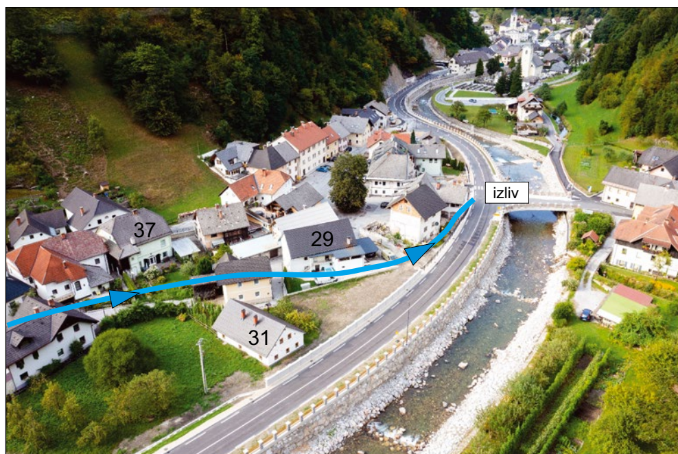
Izliv odvodnega kanala je bil pred mostom v Smolevo, ki danes stoji na istem mestu.
