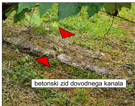
Ostanek betonsko-kamnitega zidu, ki je bil zgrajen na desni strani kanala nad hišo (Na Plavžu 84), vidna dolžina zidu je okoli 10 m. Širina zidu je 25 cm. Foto: Andrej Bogataj
