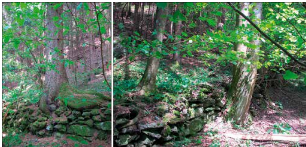
Slika 2: Pogled na suhozid na severovzhodni strani Kočevnika. Foto: Jana Horvat
