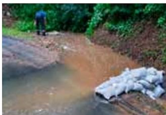
Ein kurzer, aber heftiger Starkregen führte zu Verklauungen von Durchlässen und in Folge für überflutete Keller. Es wurden Sandsackbarrieren errichtet und Keller ausgepumpt.
