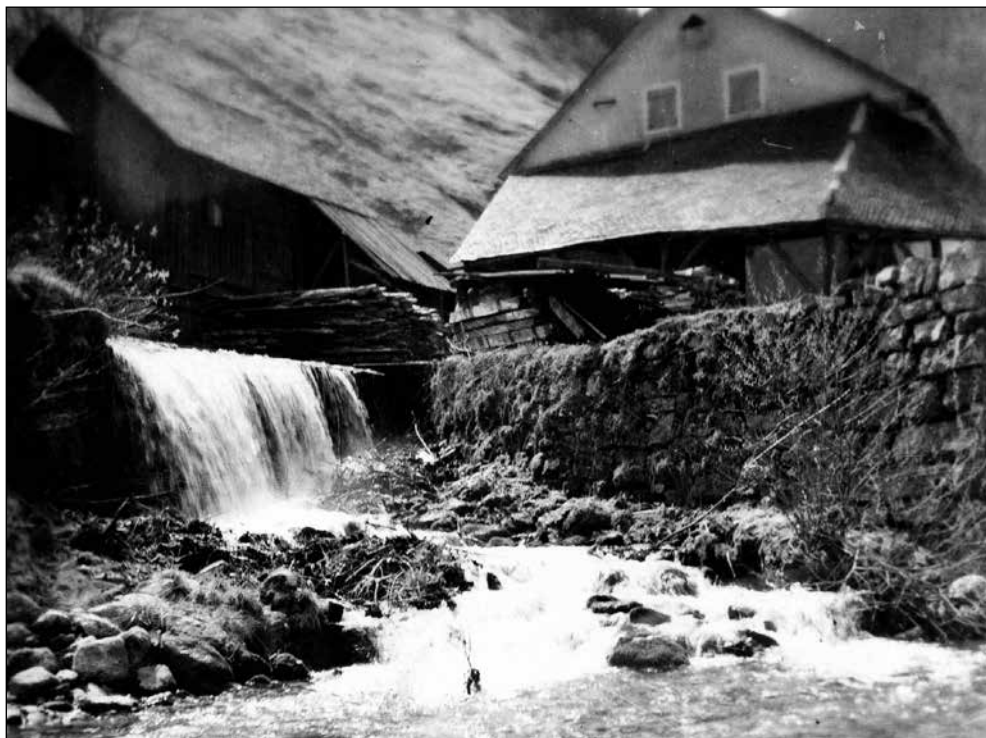
Pogled na žago (levo) in mlin Plnada (desno) z vzhodne strani iz struge Sore. Voda preko lesenega jezua teče v Soro. To je bilo samo izjemoma, če je bil bajer na Racovniku zaprt (poln). Ob normalnem delovanju naprav je voda tekla mimo in naprej po bajerju čez Racovnik. Fotografijo hranita Bojan in Aljoša Fajfar, Plnada.
