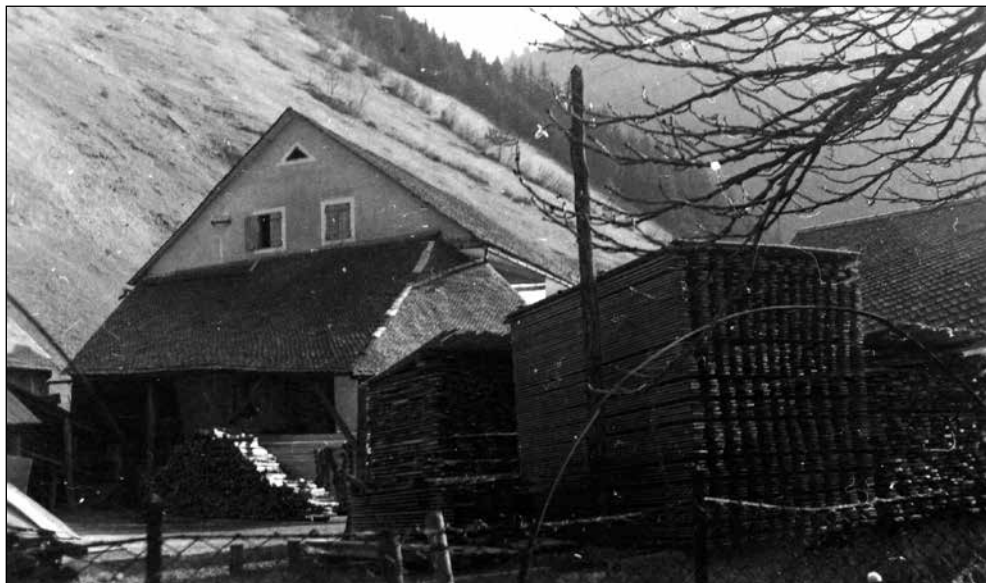
Dvorišče pred Plnado je polno razžaganih desk. Ob mlinu se vidi dograjena stavba z žago za obrezovanje desk. Na drogu se vidi štirižična električna napeljava do stavbe. Mogoče je bil za generator elektrarne uporabljen asinhronski motor, ki je za delovanje potreboval zunanje vzbujanje (omrežje). Takšna izvedba je bila lažja in cenejša. Fotografijo hranita Bojan in Aljoša Fajfar, Plnada.
