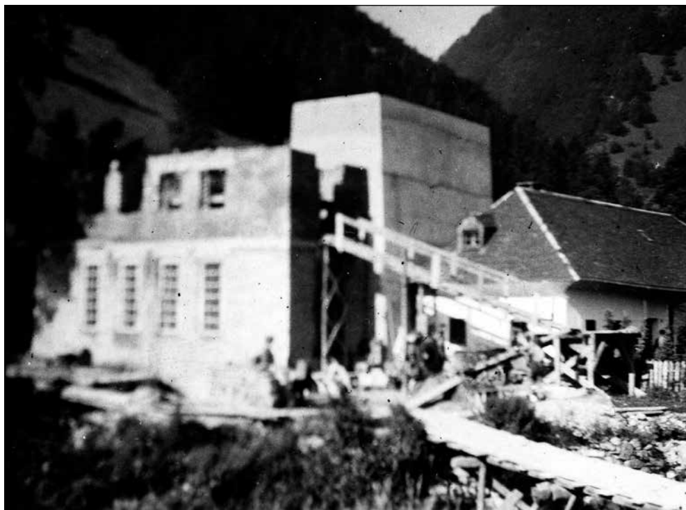
Gradnja elektrarne NIKO. Zabetoniran vodni stolp na sredini, levo gradnja stanovanja in strojnice, desno Johanov mlin, ki je mlel do leta 1950. Fotografijo hrani Peter Polajnar.
