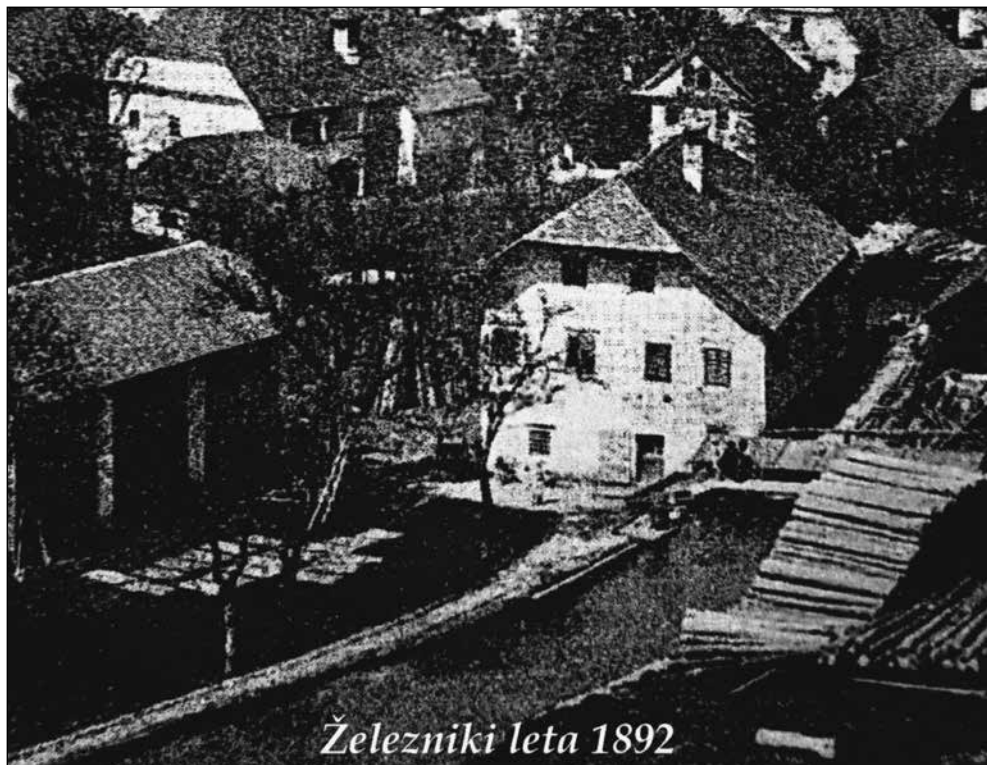
Mlin Plnada. Na desni strani so hlodi, pripravljeni za razrez. Na žago Plnada so jih transportirali tako, da so jih po vodi skozi zapornice po zaprtem pravilnem koritu pripeljali do žage. Fotografijo hrani Muzej Železniki.
