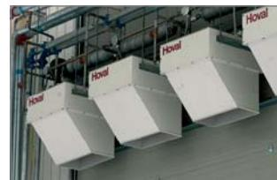
Naprave tipa TopVent® curtain preprečujejo izgube toplote zaradi odprtih vrat in prehodov.
