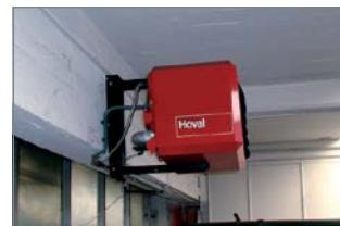
Naprave TopVent® GV so primerne za montažo na stropu ali na steni.
