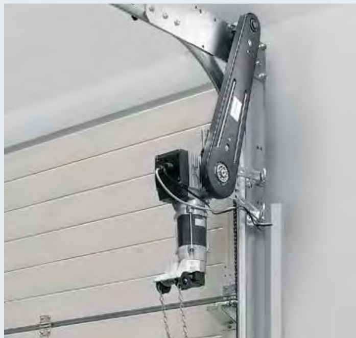
Standardni vgradni položaj navpičen, slika z opsijsko verigo za ročno upravljanje v sili
