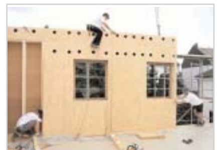
Kurze Bauzeit auch bei mehrgeschossigen Holzhäusern
