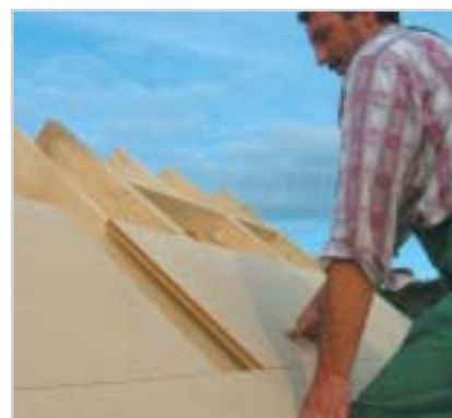
Die passgenaue Profilierung der AGEPAN® UDP 25 erlaubt zügiges Arbeiten
