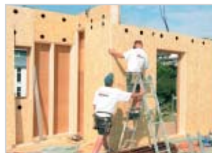
Sogar bei Frost kann der Aufbau der Wandelemente erfolgen
