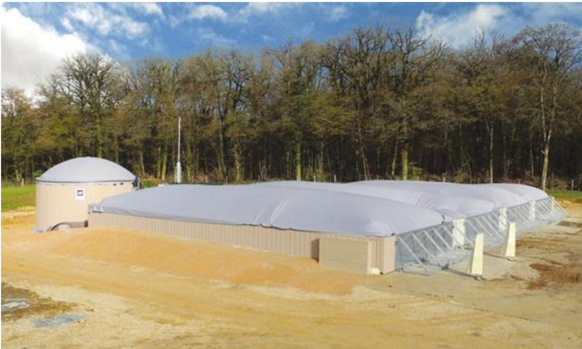
Figure 1 : L'installation voie sèche type bateau du EURL JOLY (Source Sud-Ouest Biogaz)
