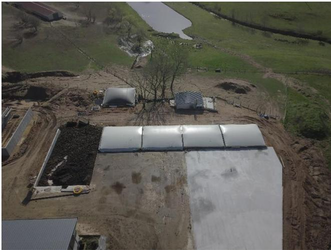
Figure 4 : L'installation voie sèche type piscine d'Agri Synergie (source Agri Synergie)
