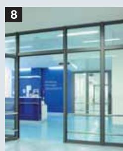
Ognjevarni in dimotesni elementi z okvirji iz cevnih profilov
